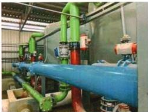
Instalación de Filtros a Presión
