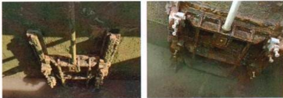
Limpieza de unidades, pintura y mantenimiento de compuertas
