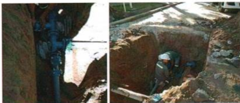
Renovación Cruce Red Distribuidora Calle Rioja y Barraquero – Ciudad: Cañería Ø 90mm Long. 73m.
