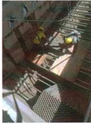
Refuncionalización e impermeabilización de Sedimentadores Unidad 1
